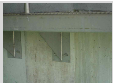
□ P4 점검로 볼트 체결 전경
