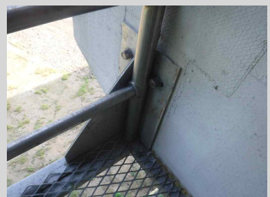
□ P2 점검로 볼트 체결 전경
