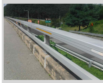
난간 및 연석 전경
