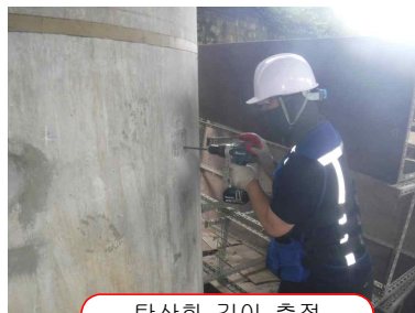
탄산화 깊이 측정
